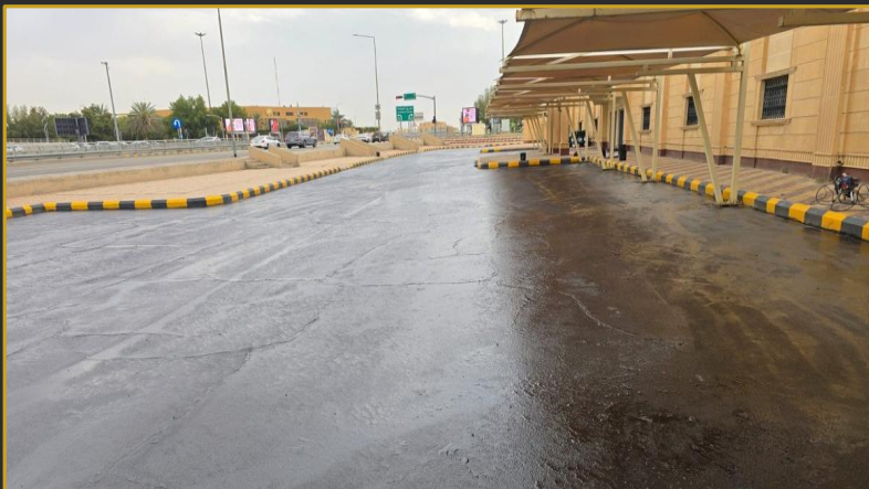
Finished Road | الطريق المنتهي
