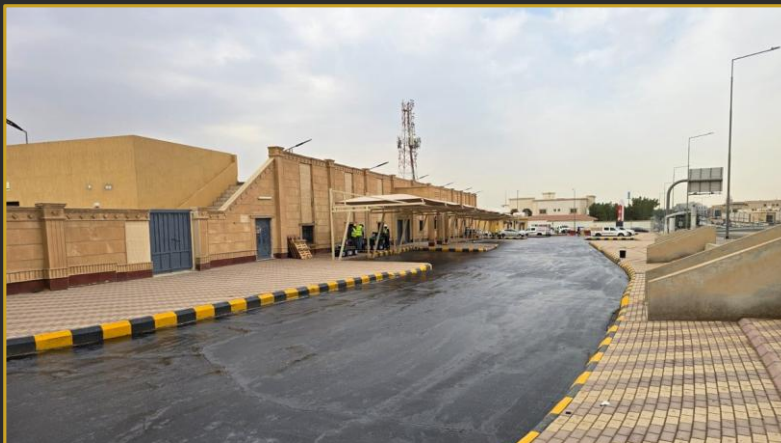
Fog Seal Application | تطبيق الختم الضبابي
