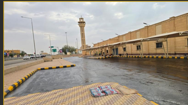
Asphalt Laying | فرش الأسفلت
